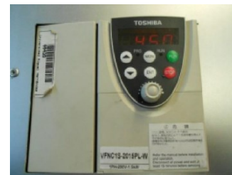
Figura A.05: Ventilador y variador de frecuencia.
