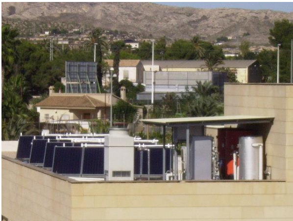
Figura 2: Instalaciones de refrigeración solar construidas por el grupo solicitante. Izquierda: Planta de absorción descrita en Martínez et al. (2012). Derecha: Instalación experimental descrita en Lucas et al. (2017).
